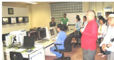
中央制御室を見学
